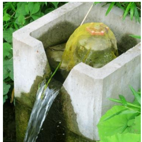
取水口にネットをかぶせる
